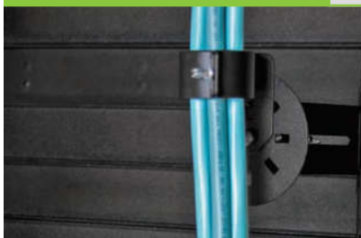
Installiertes Universal-Klemmen-Set für die Rackmontage
